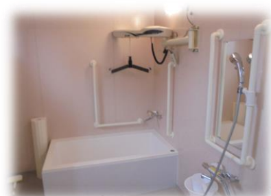
浴室 リフト設置 ストレッチャーも配置しました
